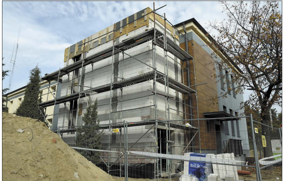
Prace modernizacyjne w przychodni prowadzone są tak, aby zapewnić jej niezakłócone funkcjonowanie
