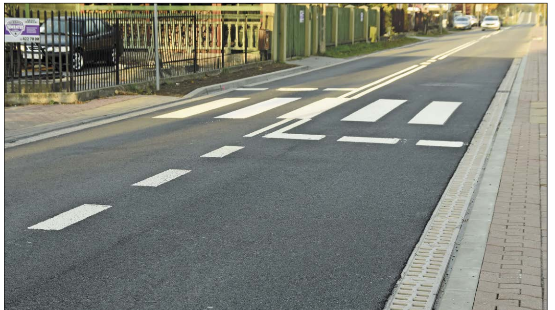
Tak wygląda zrealizowana inwestycja odwadniająca w Serocku przy ul. Nasielskiej. Przykrawężnikowe wpusty uliczne likwidują, powstające po ulewach, zastoje wodne
