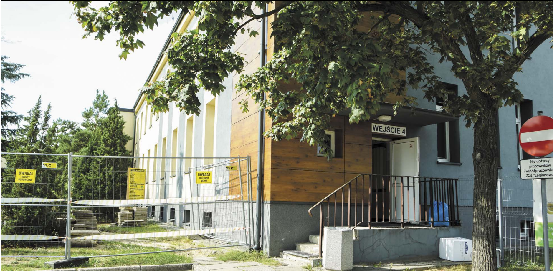
Prace rozpoczęto od przygotowania placu budowy oraz zabezpieczenia terenu inwestycji
