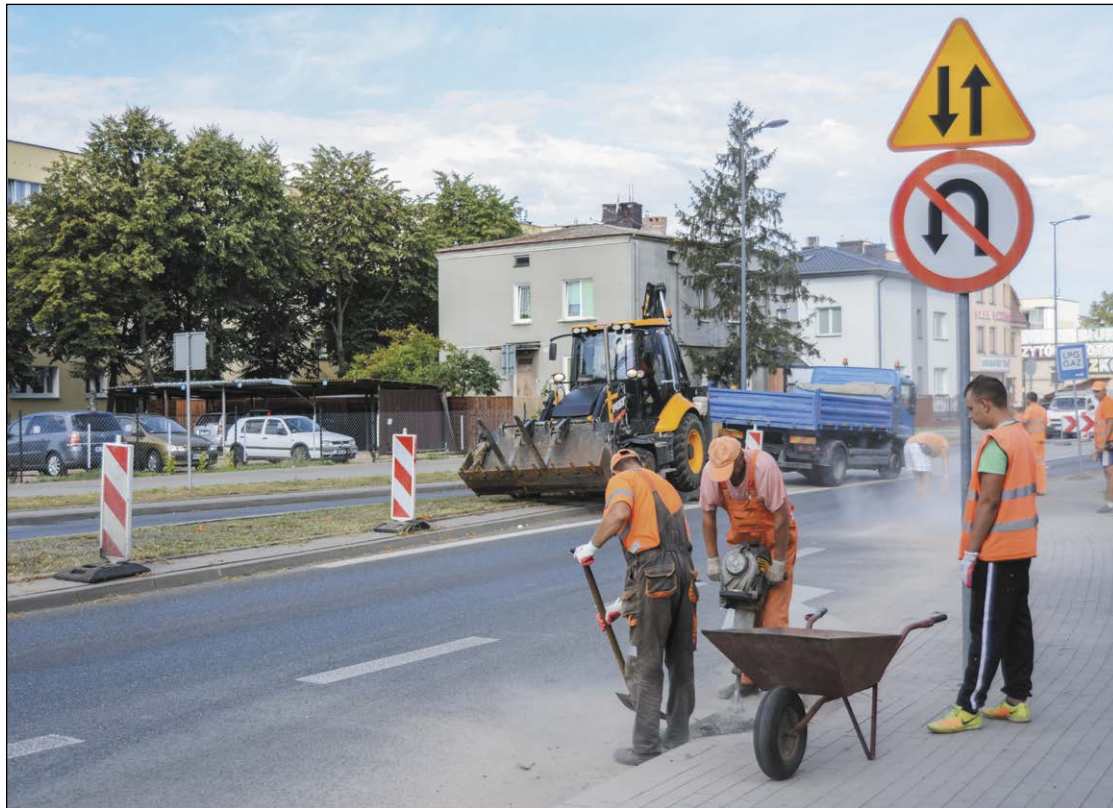
Prace przy przebudowie lewoskrętu zaplanowano tak, aby stwarzały kierowcom jak najmniej utrudnień
