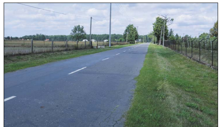
Powiat sukcesywnie remontuje zarządzane przez siebie drogi. Większe inwestycje konsultowane są z mieszkańcami, aby jeszcze na etapie projektowania uwzględnić ich potrzeby i rozważyć uwagi. Na zdjęciu droga 1807W w Karolinie, której niedaleka przebudowa była przedmiotem konsultacji społecznych
