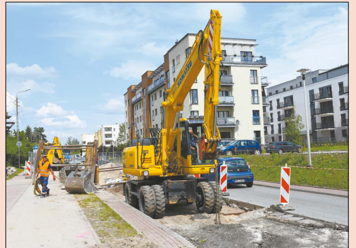
Zastosowane rozwiązania przyczynią się do efektywnego przyjęcia i odprowadzenia do gruntu wód opadowych w trakcie wzmożonych opadów
