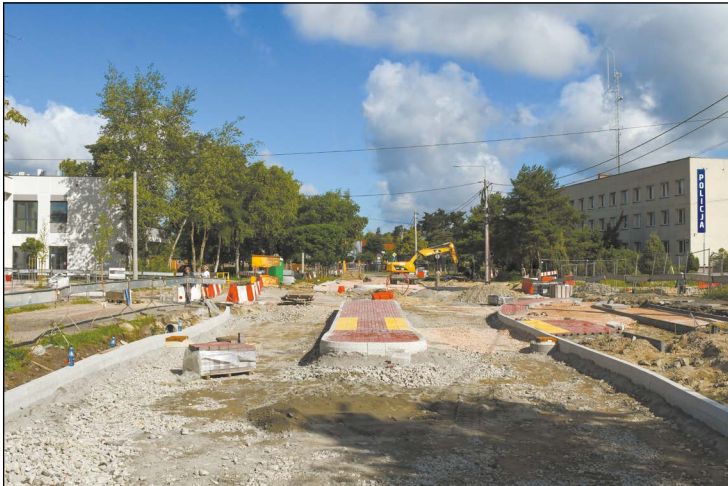
Powstające w tym miejscu rondo usprawni ruch oraz zwiększy bezpieczeństwo w tej lokalizacji
