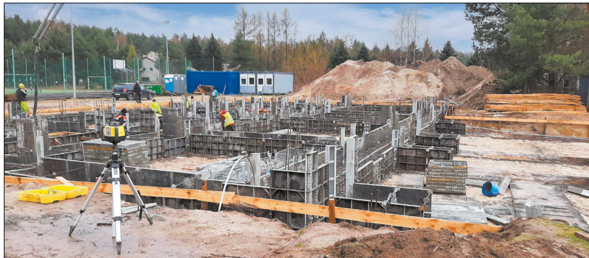
Budowa liceum potrwa półtora roku. Pierwsze efekty robót są już widoczne
