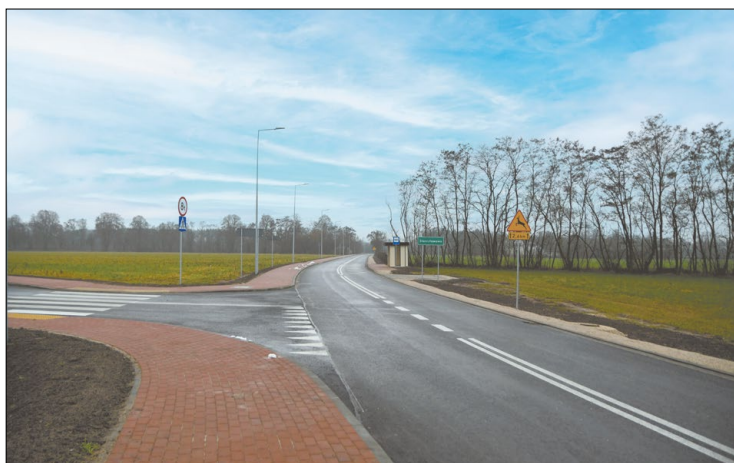
Fragment oddanej do użytku wiosną 2023 r. przebudowanej drogi powiatowej nr 1801W na odcinku Zabłocie – Stanisławowo w gminie Serock
