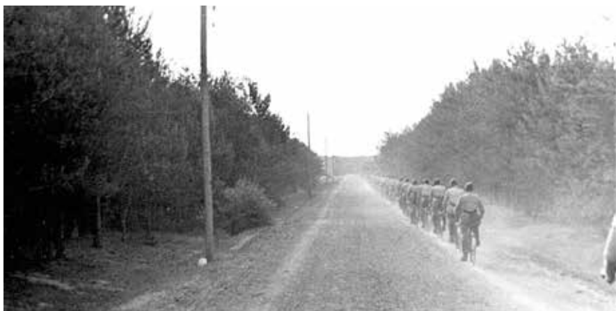
Pododdział RAD-u udający się na teren budowy schronów w Dąbkowiznie (zbiory K. Szostka)
