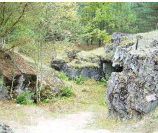
Zniszczona tylna część schronu, 2005 r. (fot. D. Wróbel)
