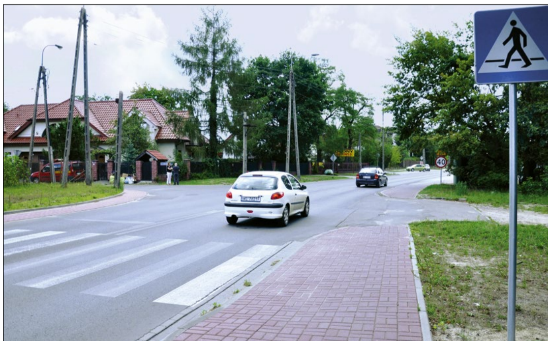
W tym miejscu powstanie skrzyżowanie o ruchu okrężnym, od którego wprawo prowadzić będzie łącznik w stronę tunelu
