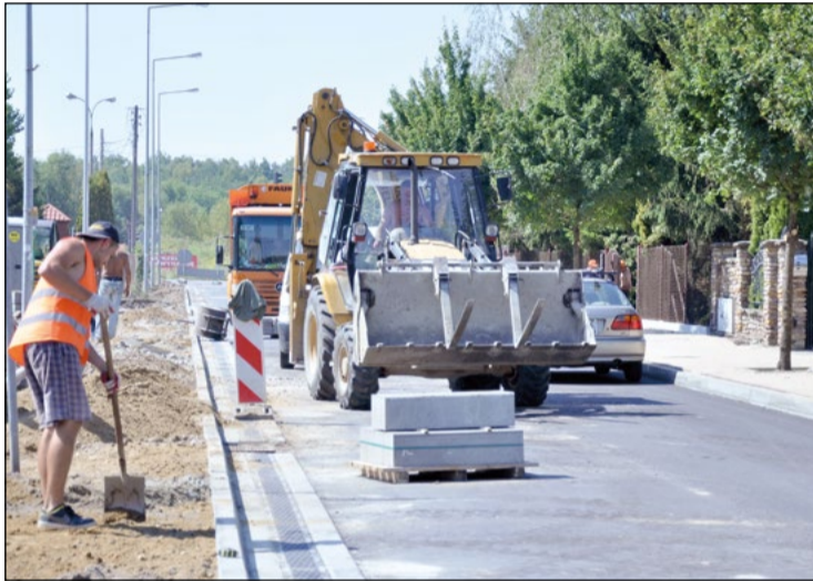
Na znacznym odcinku drogi roboty są już na ukończeniu. Na odcinku od Jana Kazimierza do Kościoła powstaje nowy chodnik
