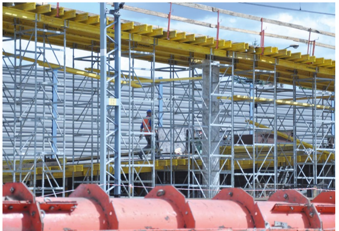
JK Szalunki pod pochylnie kładki są już przygotowane. Niedługo rozpocznie się montaż elementów konstrukcji
