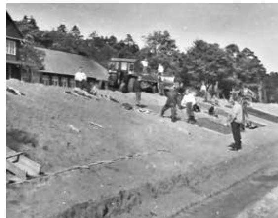
Umocnianie brzegu w Zegrzynku (arch. techn. „Hydroprojektu”)
