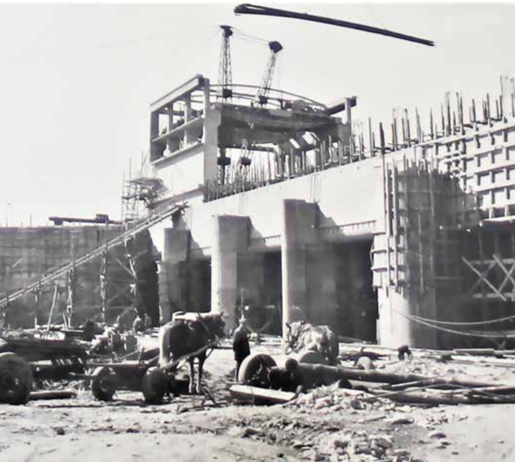
Prace przy jazach (arch. techn. „Hydroprojektu”)
