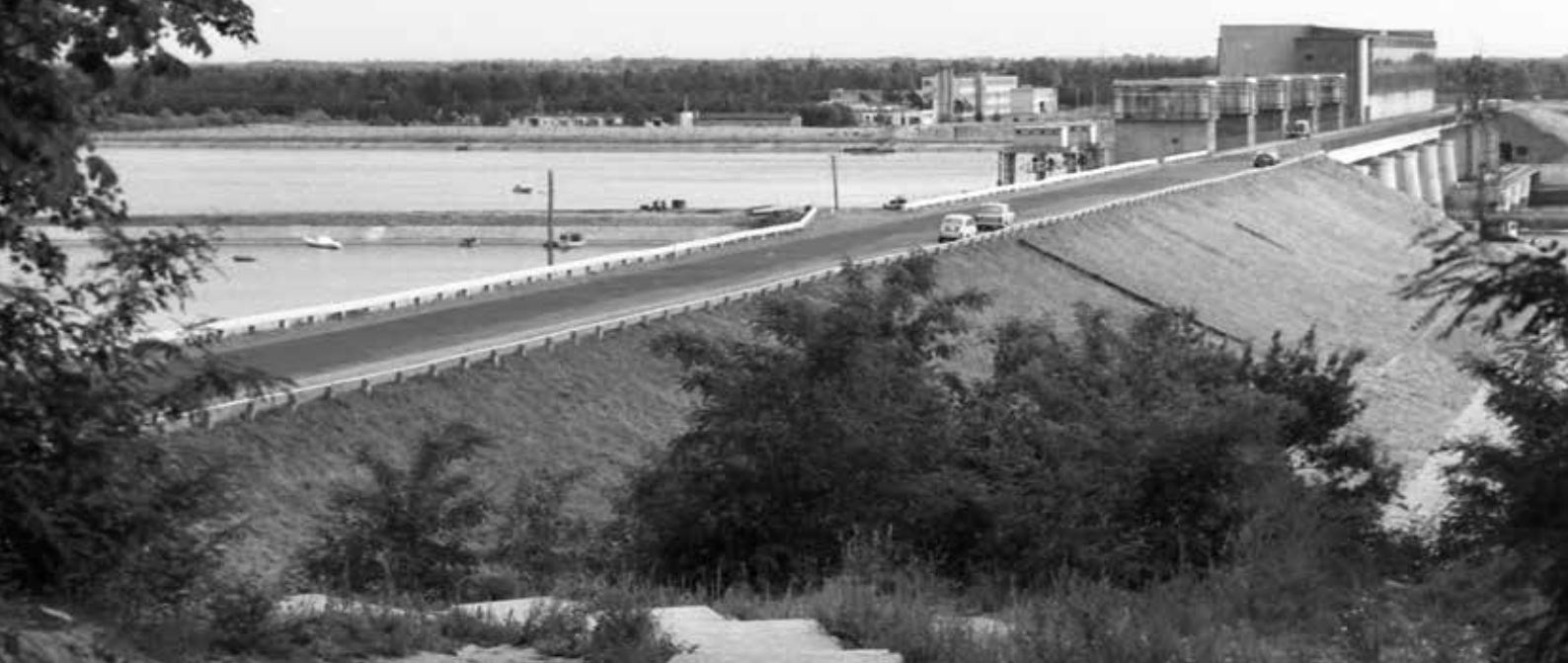
Stoپیeń Dęba po ukończeniu (arch. tech. „Hydroprojektu”)
