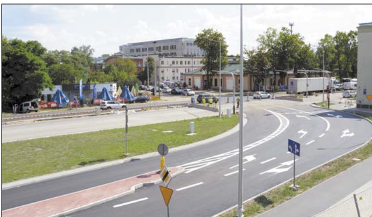
Poprawa bezpieczeństwa na drodze, zwiększenie przepustowości oraz poprawa jakości komunikacji samochodowej to główne założenia prowadzonej od października 2018 r. przebudowy DK61
