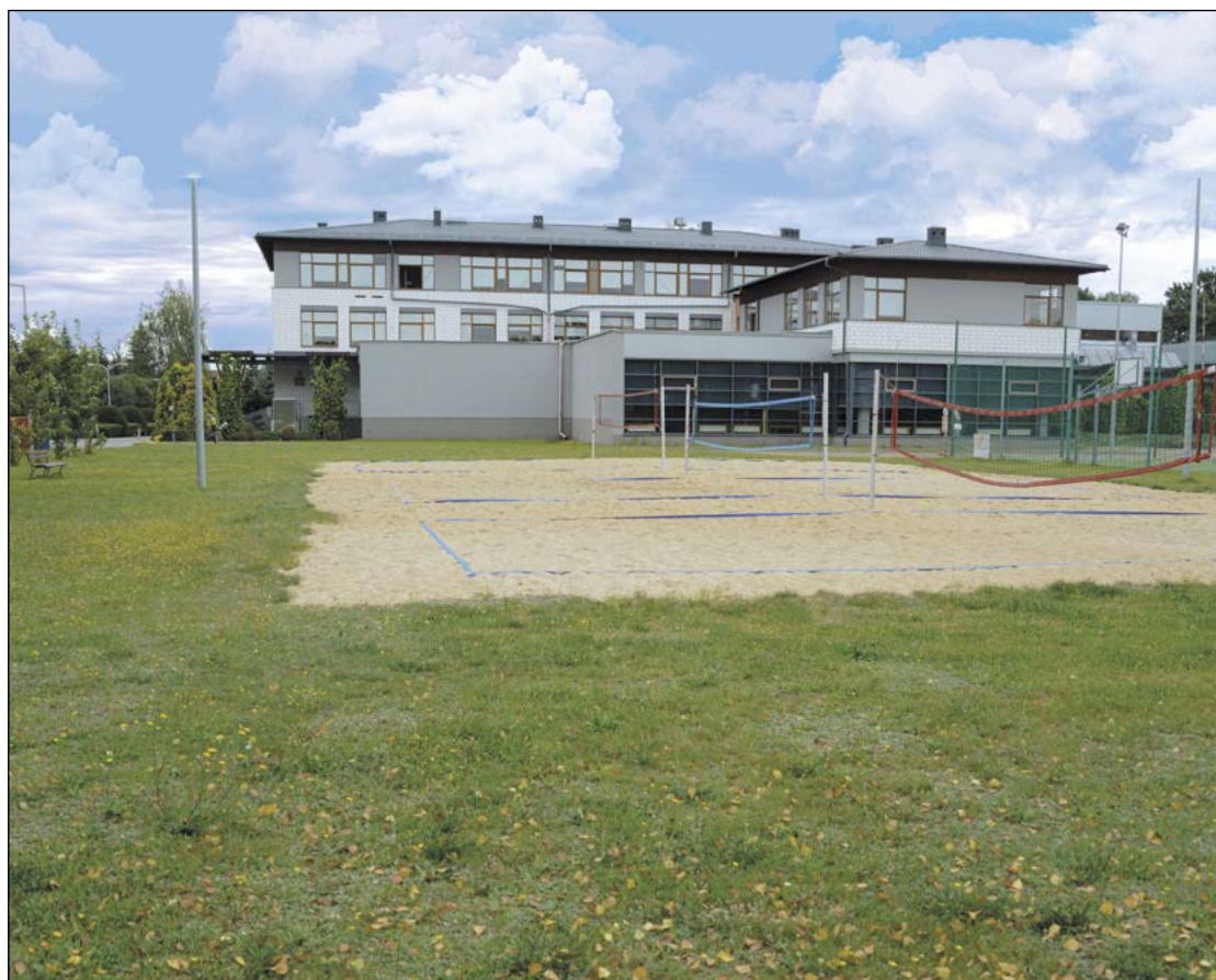
Działka w Stanisławowie Pierwszym przeznaczona na cele oświatowe ma powierzchnię 23 tys. m 2 , z tego ok. 4,5 – 5 tys. m 2 jest wciąż wolnych pod zabudowę. Budynek Liceum Ogólnokształcącego im. Stanisława Lema powstanie obok szkoły podstawowej
