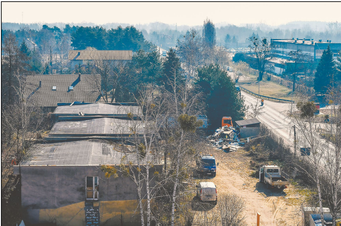
Już wkrótce rozpadające się budynki, które znajdują się w bezpośrednim sąsiedztwie starostwa, zostaną rozebrane, a w ich miejscu powstanie parking
