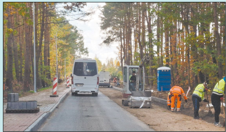
Prace w Stanisławowie zbliżają się do końca. Wykonywana jest nawierzchnia jezdni, a następnie pojawiają się oznakowania poziome i pionowe
