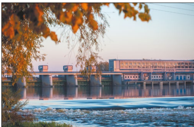
Fot. Sebastian Stankiewicz „Zapora wodna w Dębem”
