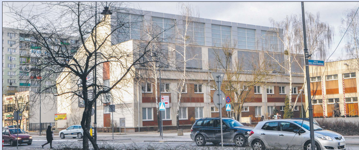
Rozpoczęcie prac na dachu PZSO w Legionowie zaplanowano na drugi kwartał br.
