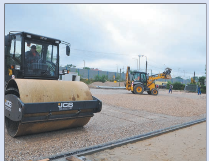
Prace budowlane idą pełną parą. Uczniowie PZSP w Legionowie już wkrótce będą cieszyć się nowoczesnym boiskiem
