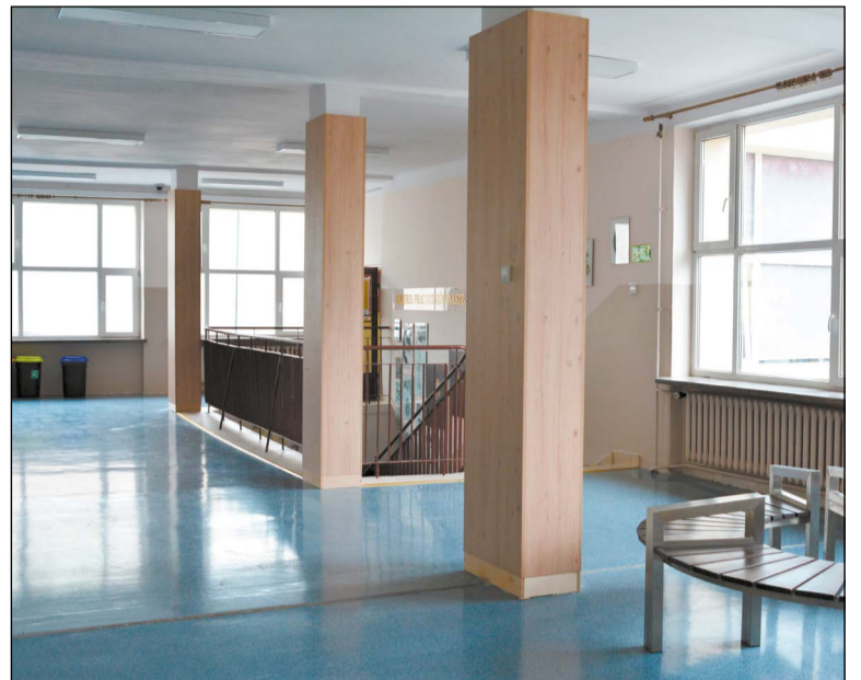
Odbiory techniczne remontów przebiegły bez zastrzeżeń. Uczniowie oraz pracownicy placówek mogą już bez przeszkód korzystać z odświeżonych pomieszczeń
