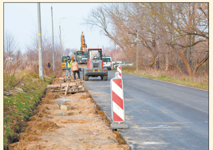
Jeszcze w tym roku przebudowywany odcinek drogi nr 1817W zostanie oddany do użytku
