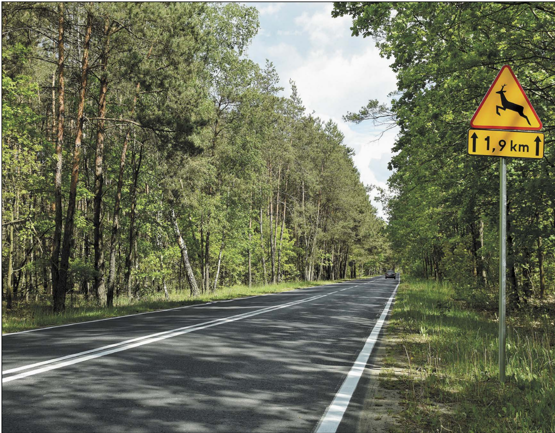
Inwestycja zakłada budowę ścieżki pieszo-rowerowej oraz modernizację jezdni na odcinku wzdłuż nowego ciągu
