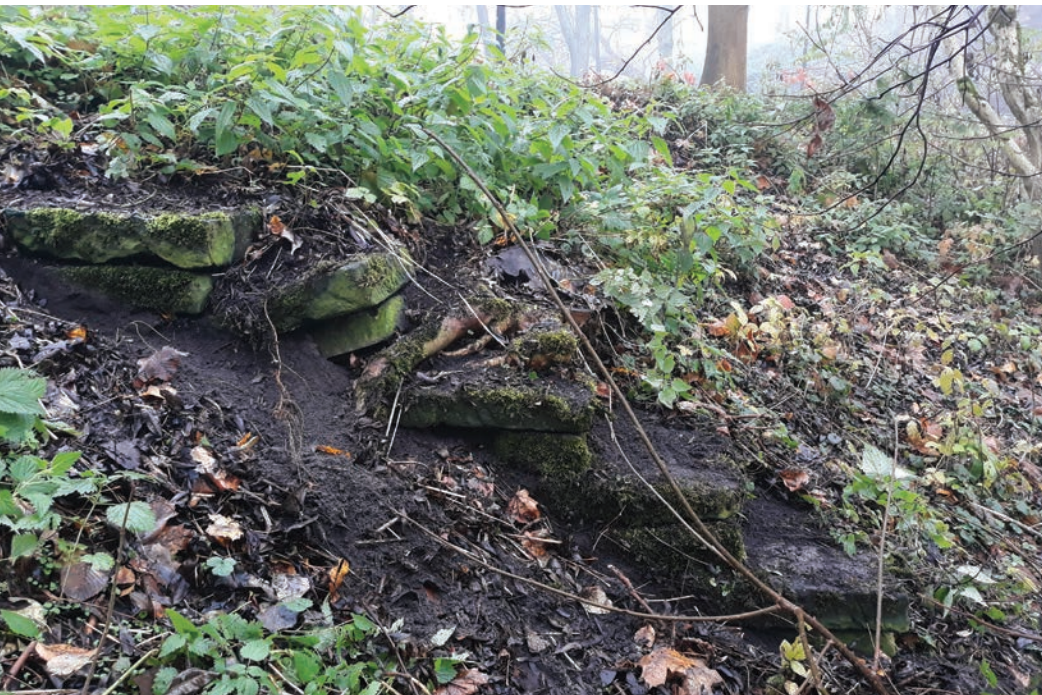
Fragment schodów z macew na wzgórzu grodowym Barbarka, 2021 r. (fot. M. Pakuła)
