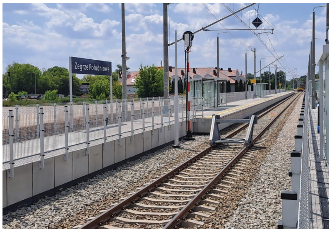
Peron przystanku kolejowego otwartego w 2023 r. (fot. autor)
