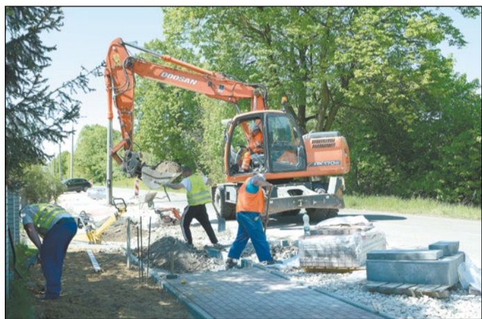
Sprzyjająca pogoda pozwoliła wykonawcy bez problemów zakończyć prace budowlane w terminie określonym w umowie z Powiatem
