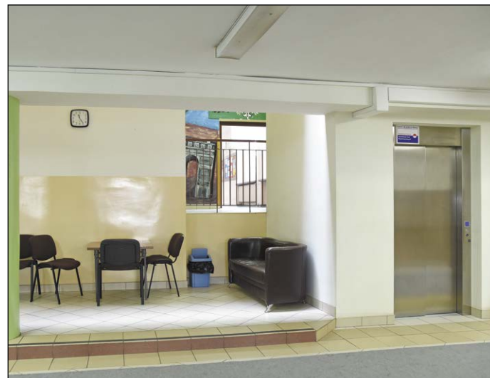
Budowa toalety w PZSO w Legionowie do kolejnego kroku na drodze do dostosowania placówki do potrzeb osób niepełnosprawnych. Sanitariat powstanie na parterze, we wnęce obok windy
