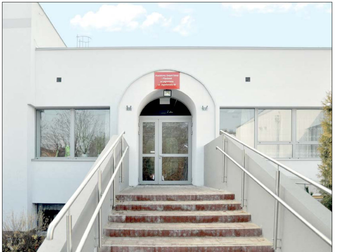
Powiatowy Zespół Szkół i Placówek Specjalnych w Legionowie został rozbudowany i poddany termomodernizacji. Inwestycję sfinansowały wspólnie powiat legionowski i wszystkie gminy powiatu
