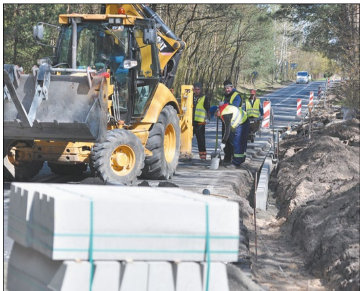
Przebudowę powiatowej drogi nr 4303W rozpoczęto od strony Beniaminowa. Ruch na remontowanym odcinku odbywa się wahadłowo
