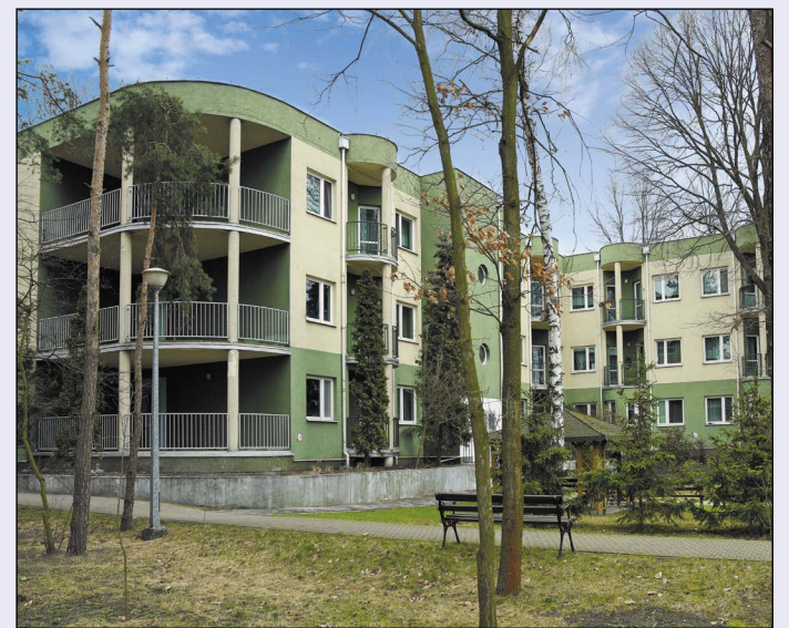
Zakres prac remontowych przeprowadzonych w DPS „Kombatant” objął m.in. modernizację balkonów i tarasów
