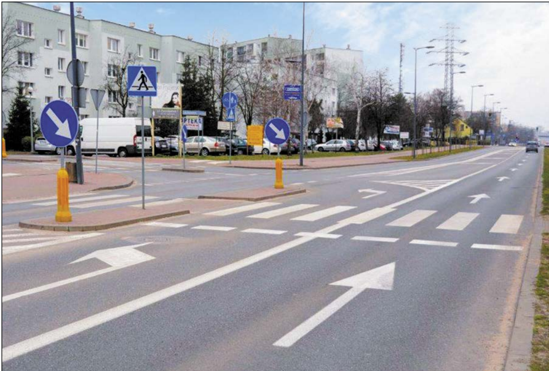
Dwa przejścia – na ul. Sobieskiego przy skrzyżowaniu z ul. Zwycięstwa w Legionowie (na zdjęciu) oraz na ul. Kordeckiego przy skrzyżowaniu z ul. Lipową w Chotomowie, zostaną przebudowane, aby zwiększyć bezpieczeństwo pieszych
