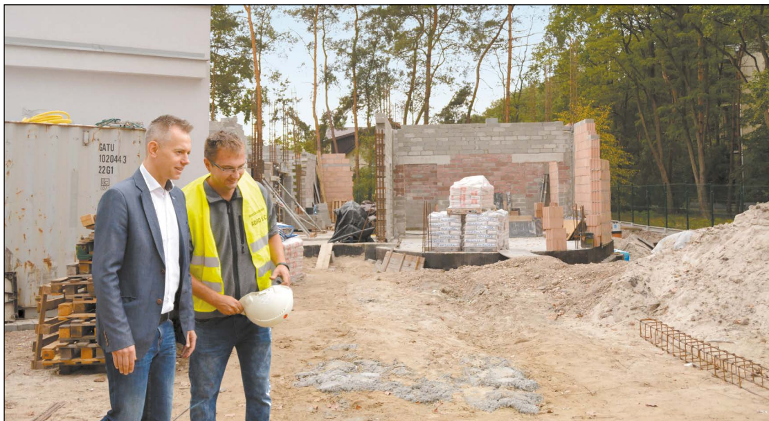
Największy problem na budowie stanowi poziom wód gruntowych. O bieżącej sytuacji z kierownikiem budowy Adamem Biezuńskim rozmawiał starosta Robert Wróbel
