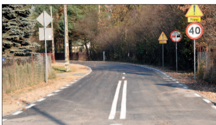
Wyrównana i utwardzona ul. Bindugi
