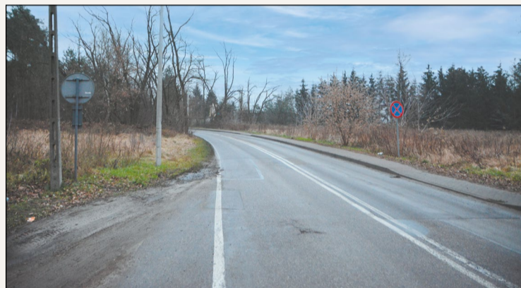
Droga 1810W wymaga modernizacji. Jej przebudowę zaplanowano w tym roku
