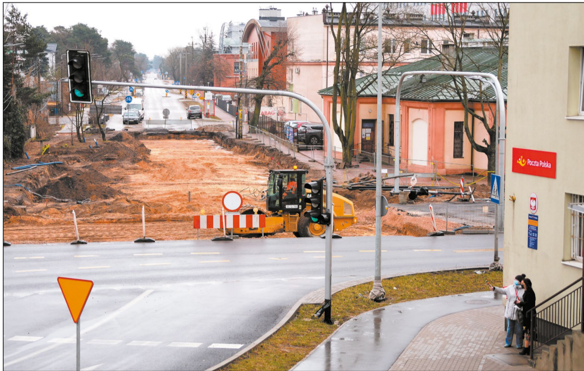
Na ul. Strużańskiej trwają prace obejmujące usunięcie kolizji drogowych, budowę chodników i ścieżek rowerowych
