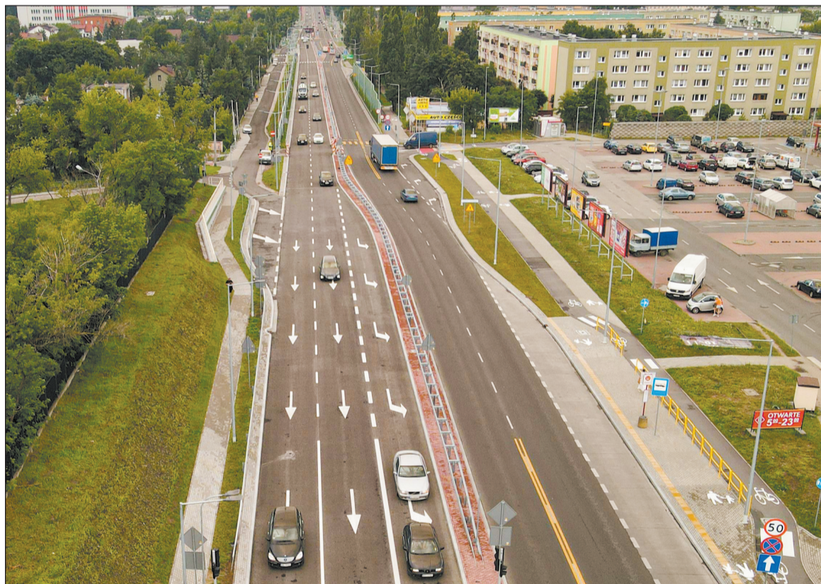
Kierowcy mogą już korzystać z poszerzonej DK 61 na odcinku od wiaduktu w Legionowie do ul. Polnej w Michałowie Reginowie
