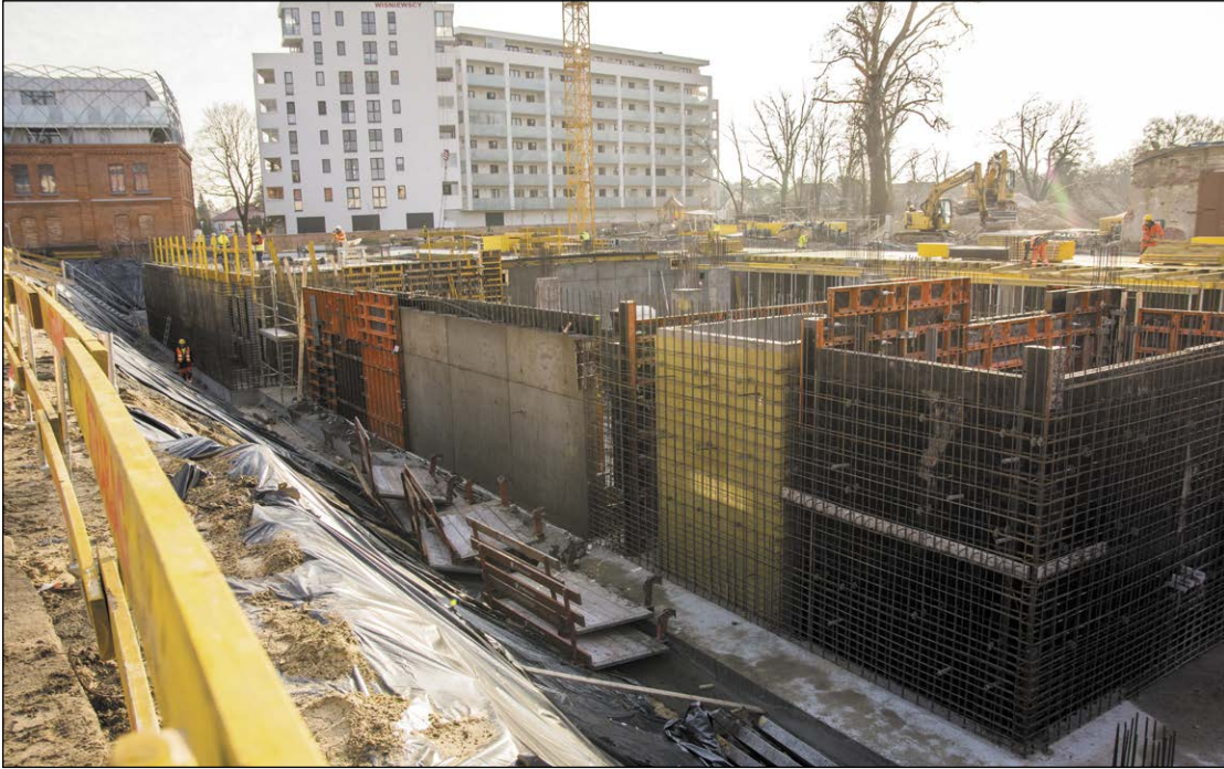
Wykonawca robót nie zwalnia tempa. Sprzyja temu nie tylko zaangażowanie ekipy, ale i pogoda, która jest dla budowlanców łaskawa
