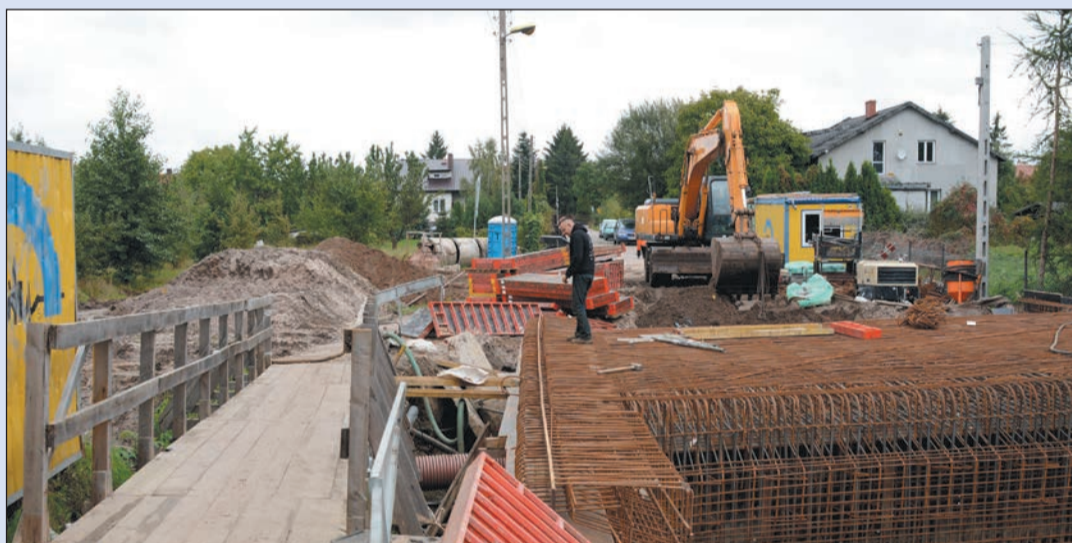
AMZ Prace przy budowie mostu w Łajskach przebiegają zgodnie z harmonogramem
