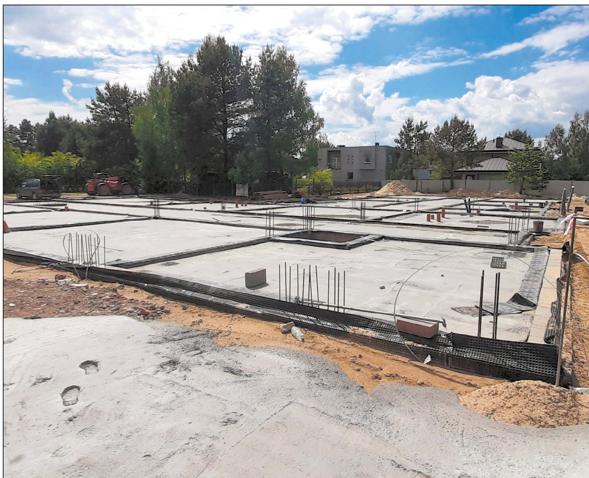
Budowa liceum w Stanisławowie Pierwszym potrwa półtora roku. Fundamenty zostały już wylane i zasypane. Rozpoczęły się prace naziemne. Pierwsze efekty robót są już widoczne
