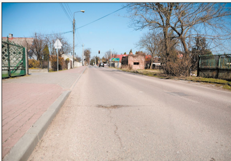
Droga powiatowa nr 1817W w gminach Jabłonna i Wieliszew wymaga modernizacji. Na realizację tej inwestycji Powiat Legionowski pozyskał dofinansowanie z Rządowego Funduszu Inwestycji Lokalnych
